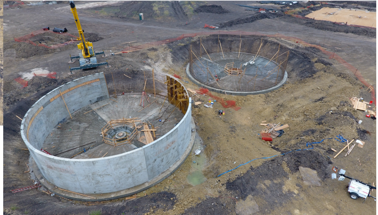
Clarifiers 1A & 1B
